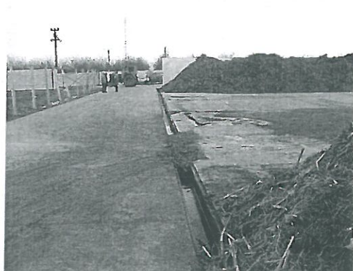
Canalul colector si directionare lichide / Bazinul vidanjabil de colectare lichide
